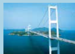
来島海峡大橋
